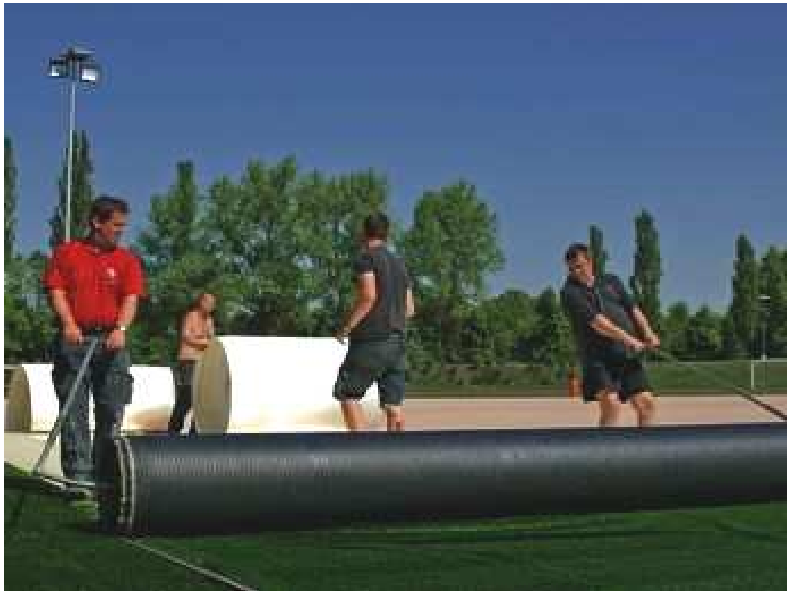
Verlegen des Rollrasens
