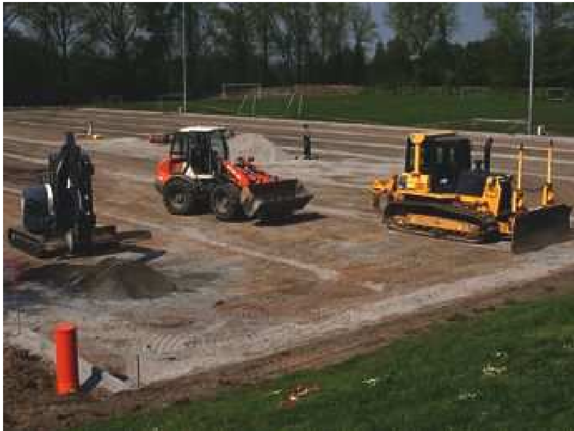
Aufbau des Unterbodens
